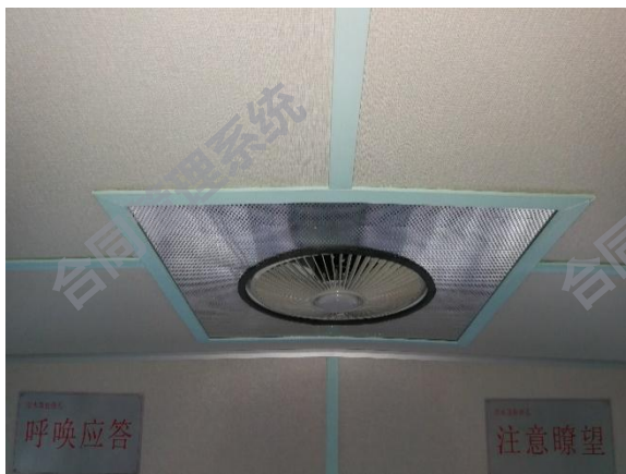
图 2-18 吸顶式风扇安装示意
